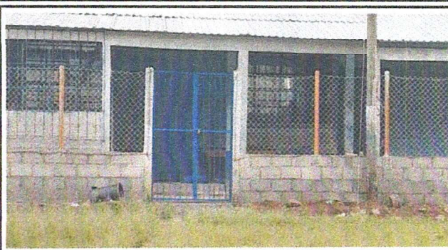
Foto 2: Colocacion de Porton de metal y circulacion de muro perimetral
