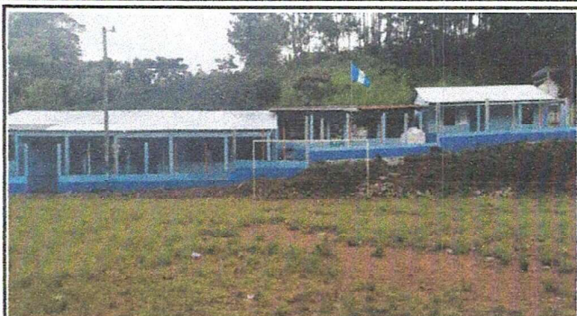
Foto1: Pintura de muros exterior e interior del centro educativo
