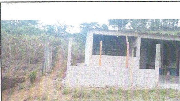
Foto 4. Terminación de muro de contención
